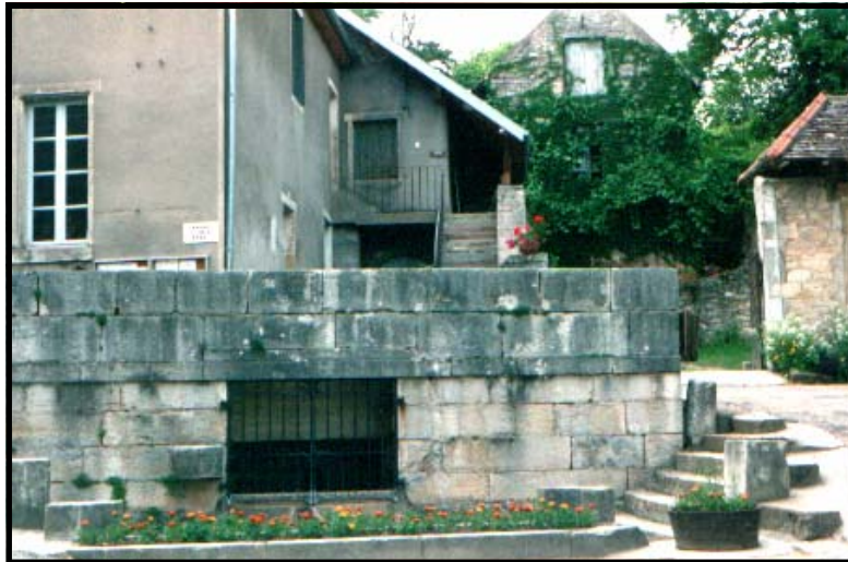
Impasse du four banal et son ancien lavoir
